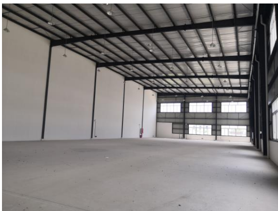
图 2-6 项目厂房内部现状图
